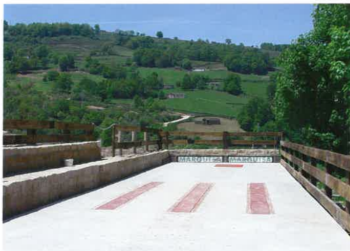
Bolera de "El Rosario" tras las obras
