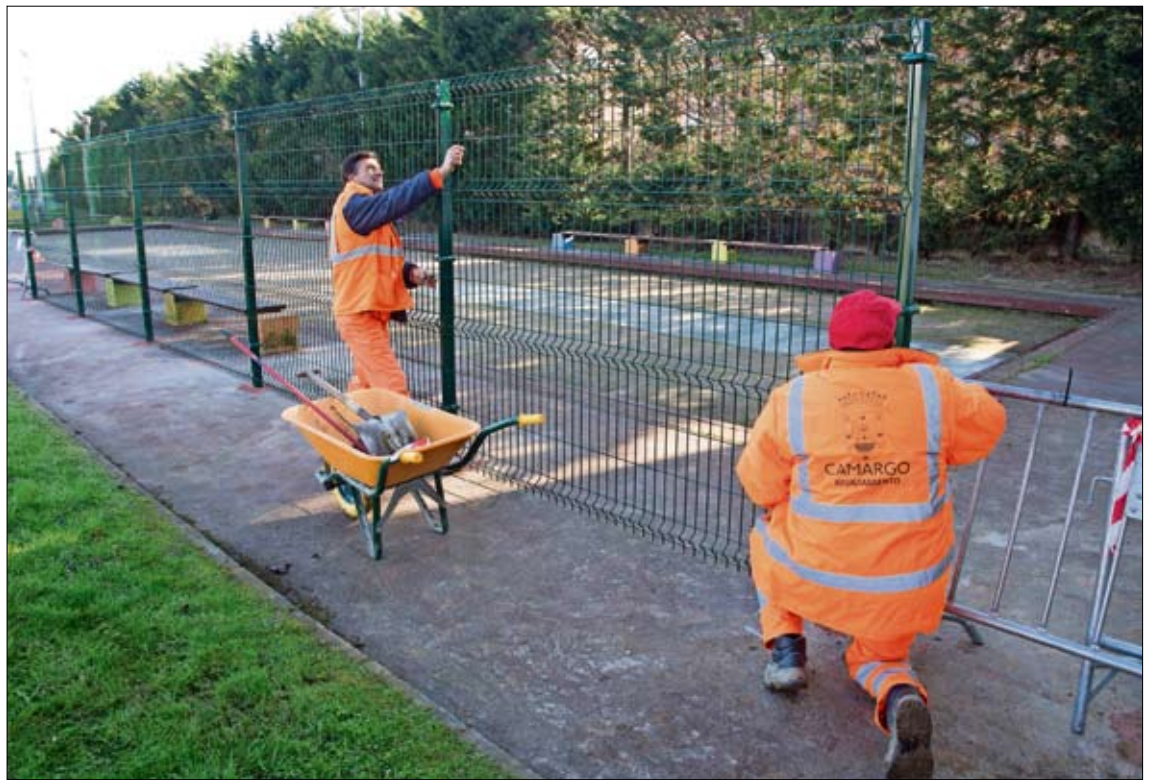
Los empleados del Ayuntamiento de Camargo colocando el vallado. / IBÁÑEZ
