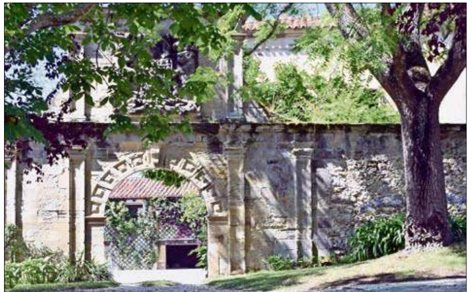
Portalada del ‘Palación’ en el barrio de Losvia.
