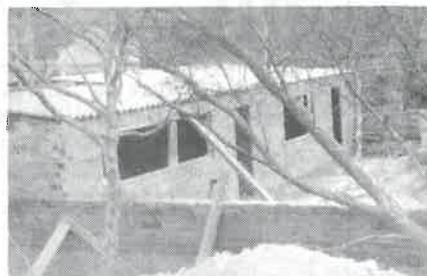
Locales de la Peña en construcción
