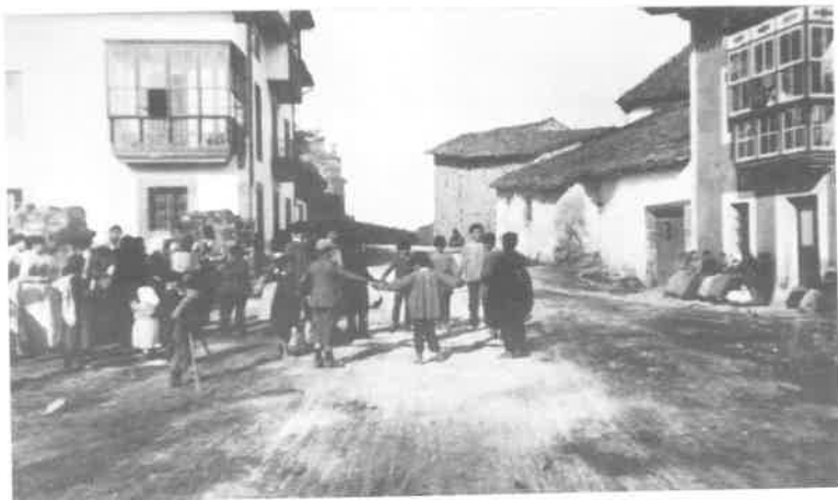
Antigua carretera, Nac. 634 Santander - Oviedo a su paso por Quijas.
