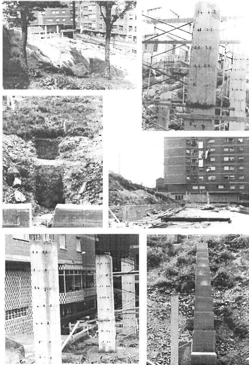
Construcción de la bolera El Verdoso
