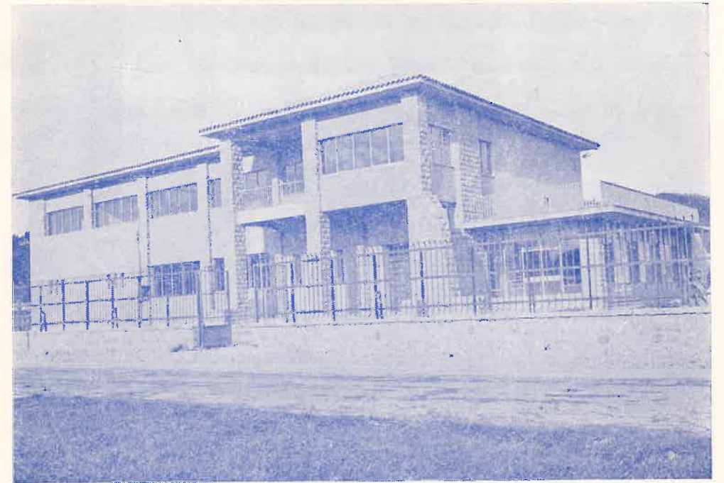
Edificio Central del Centro Social Santiago Galas Arce
