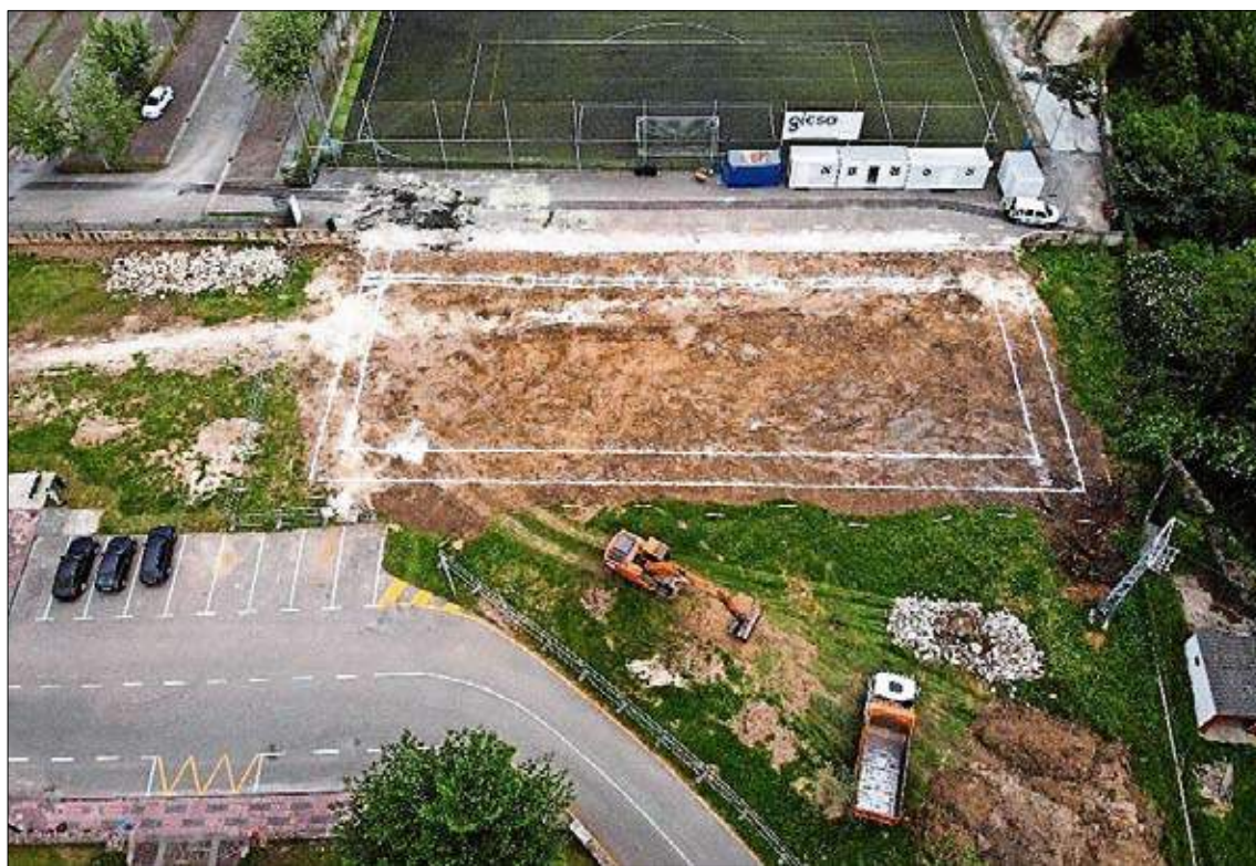
Vista aérea de los primeros movimientos de tierra.
