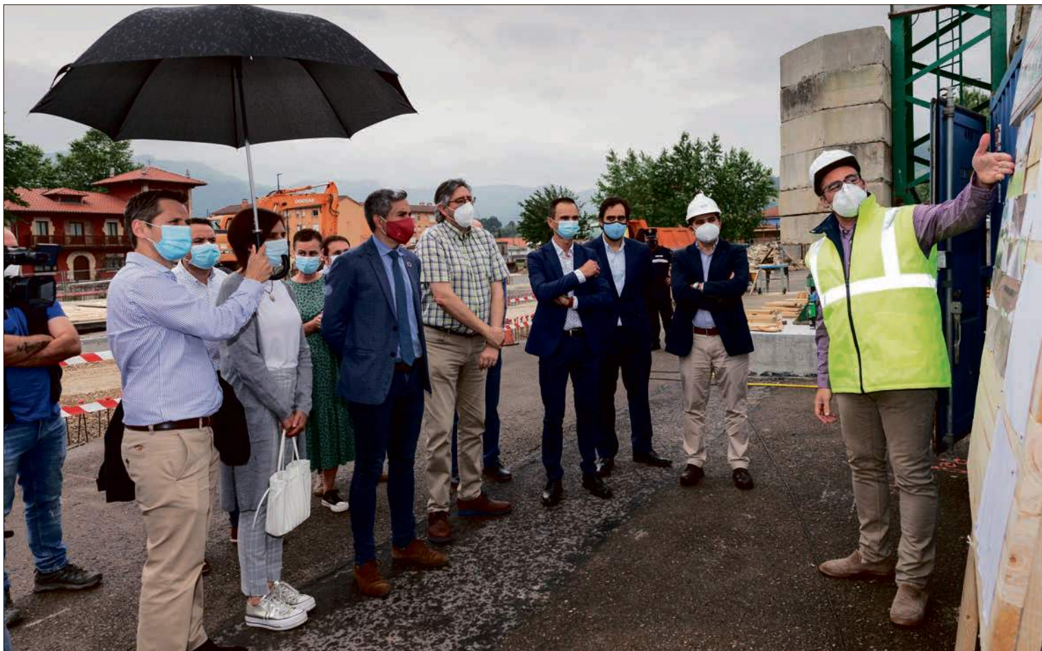
Autoridades regionales y municipales durante su visita a las obras de la bolera cubierta de Los Corrales. / ALERTA
